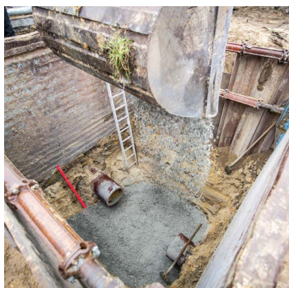
Aanleggen van de funderingsgrondslag
