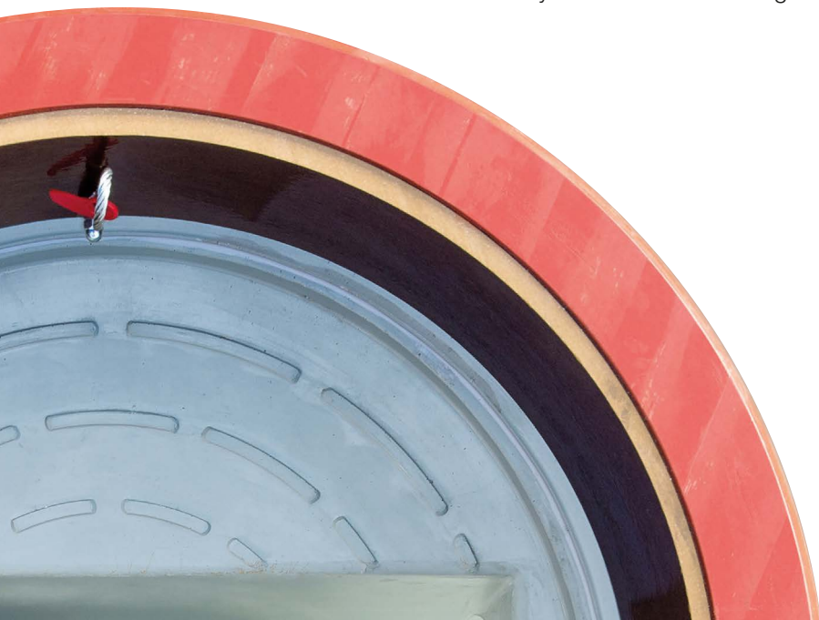
Basiselement voorbereid voor bodemelement
