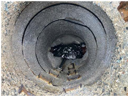
Toestand vóór renovatie:
