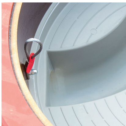
Transportanker aan binnenwand
