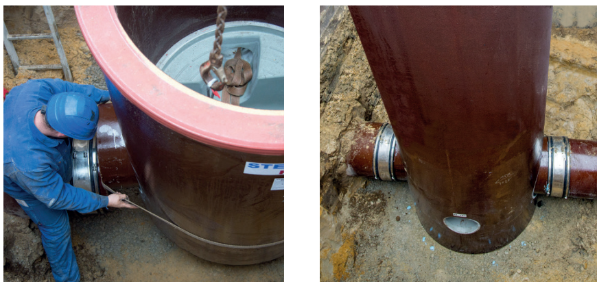
Plaatsen van de inspectieput
