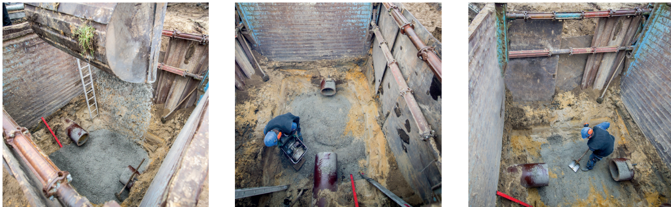
Aanleggen van de funderingsgrondslag
