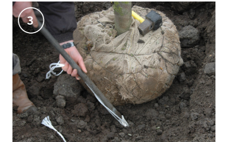
3 Breng de keeper d.m.v. de drijfstang aan in de grond.
