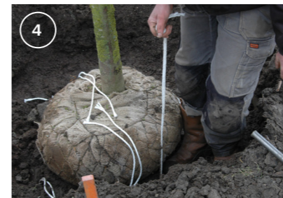
4 Trek aan het zojuist ingebrachte touw. De keeper kantelt hierdoor en zet zich vast in de grond.
