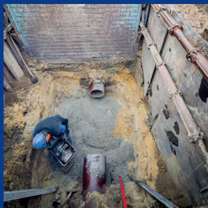
Fundering toezichtspuit plaatsen
