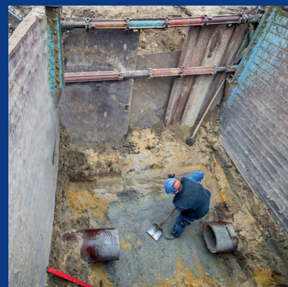
Fundering nivelleren
