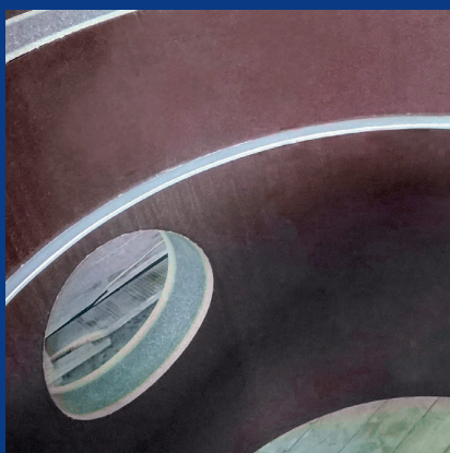
Basiselement voorbereid voor bodemelement
