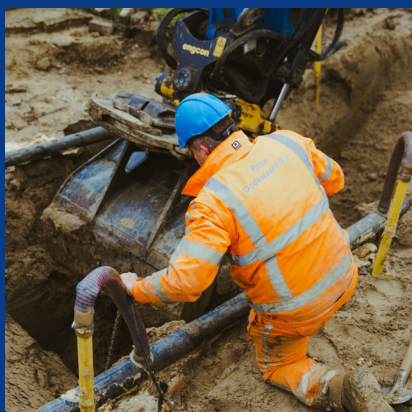
Uitgraven en beschoeien bouwput
