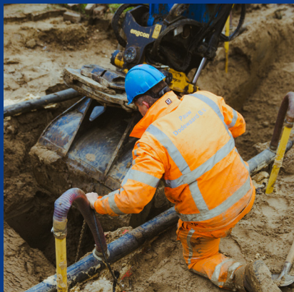
Uitgraven en beschoeien bouwput
