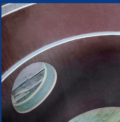
Basiselement voorbereid voor bodemelement
