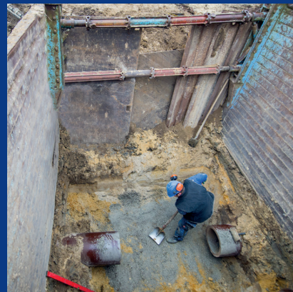
Fundering nivelleren
